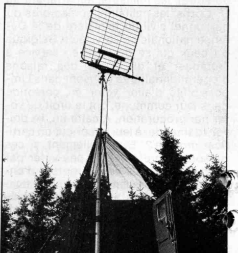
L'ANTENNE DU « MRC-8 », LA DERNIÈRE VENUE DU LOT DES CABINES DE CABLES HERTZIENS, ATTIRE L'ATTENTION.
